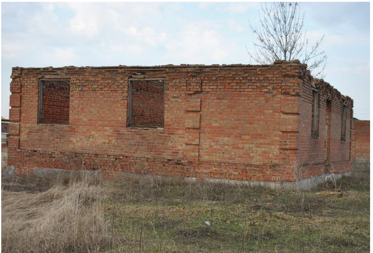
Фото Объекта незавершенного строительства, Литер Ж. общей площадью 136,4 кв.м. степень готовности 45%
